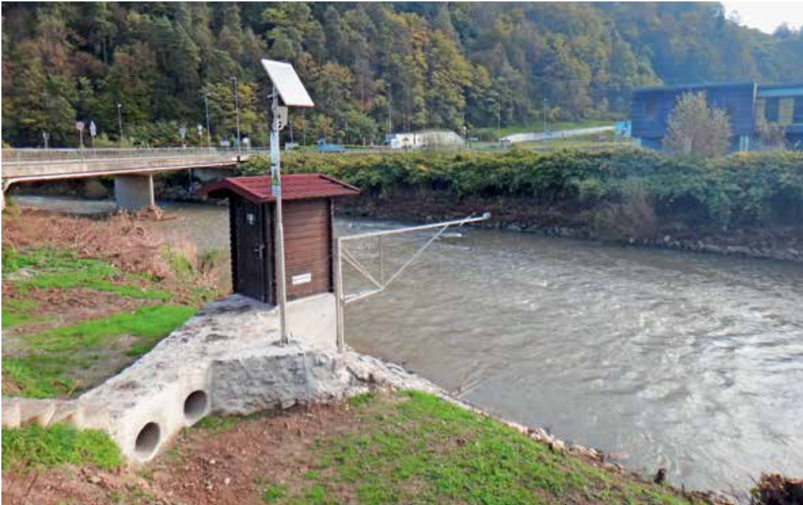
Merilno mesto Otiški Vrh na Meži Discharge surface of the water measurement Otiški Vrh on the Meža River
